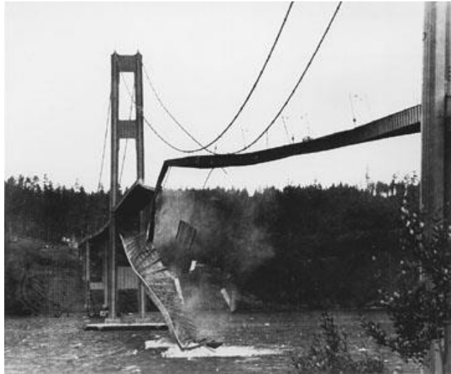
Figura C 3.8.3.2.2. Fenómeno de flameo en el Puente de Tacoma Narrow.
