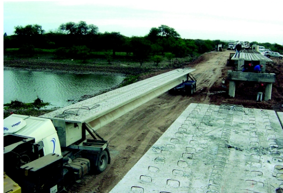
Montaje viga L = 25 mts.
