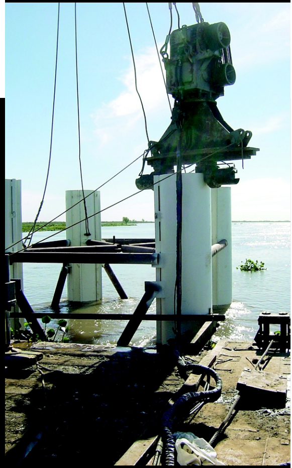
Hincado por vibroflotación de la cámara de carga
