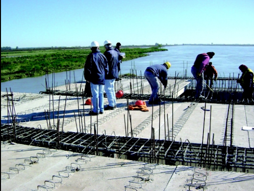
Plataforma de maniobras previo al hormigonado definitivo
