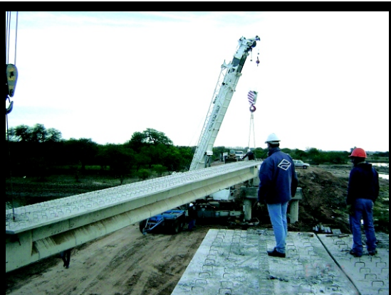
Transporte Viga pretensada para Viaducto
