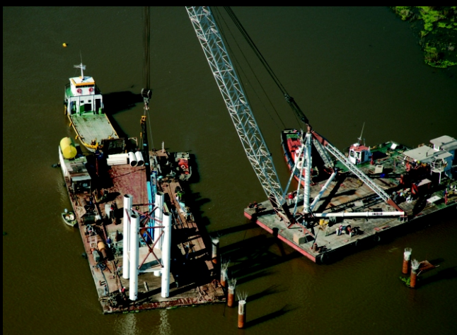
Montaje de la cámara de carga
