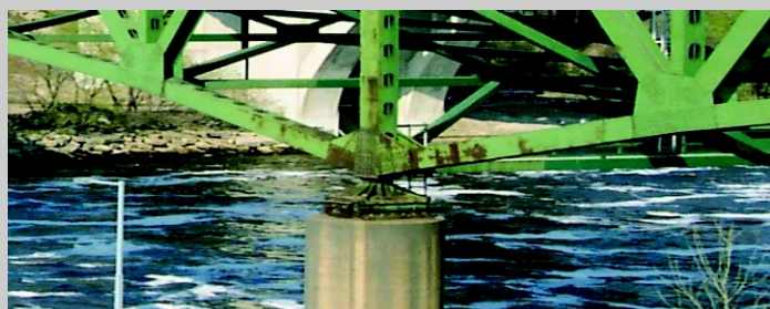
Fuertes signos de corrosión en el nudo inferior de Apoyo, cordón inferior y montante principal.
