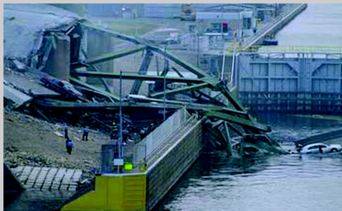
Rotación sobre el pilar aguas arriba. Observar que el nudo inferior de la viga entramada aguas arriba está aún armado.
