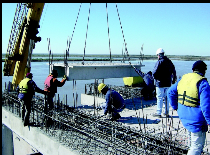
Montaje de vigas en plataforma de maniobras
