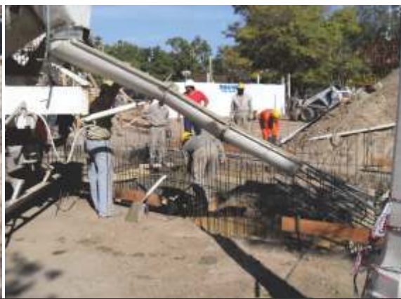
Derecha: Proceso de hormigonado
