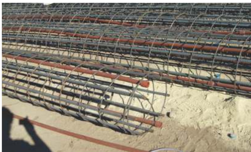
Armadura de pilotes y cañerías para la inyección de precarga
