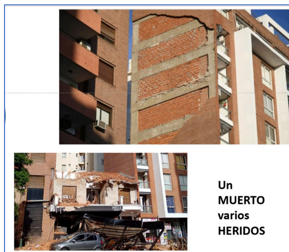
Figura 1 - Falla reciente en la envolvente de un edificio habilitado
