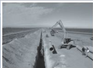
Acueducto Trelew- Madryn
