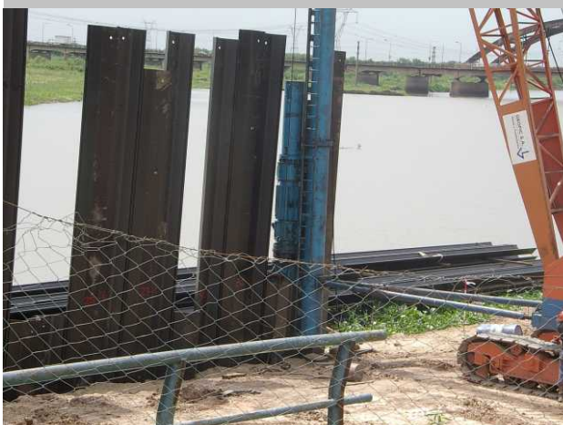
Hincado de tablestacas
