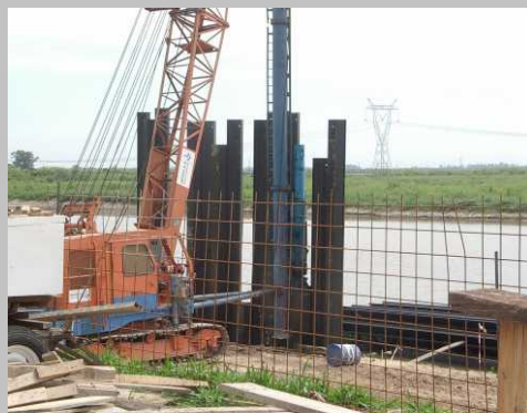
Hincado de tablestacas
