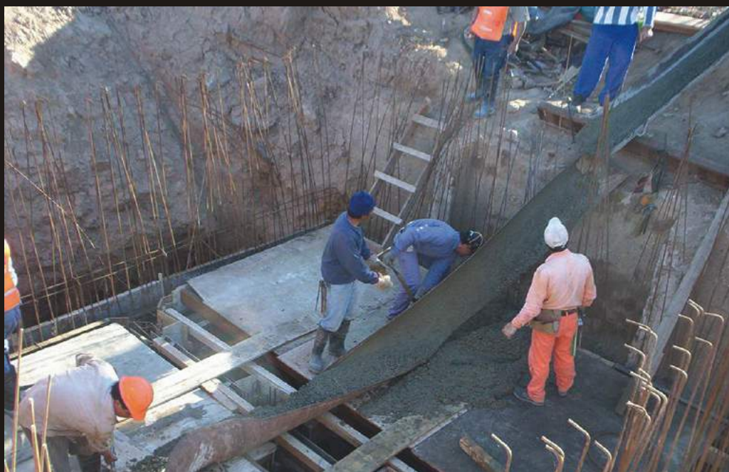
Hormigonado de cámara de calle Aldao
