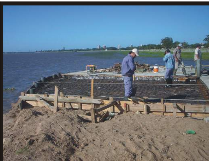
Hormigonado losa espigón.
