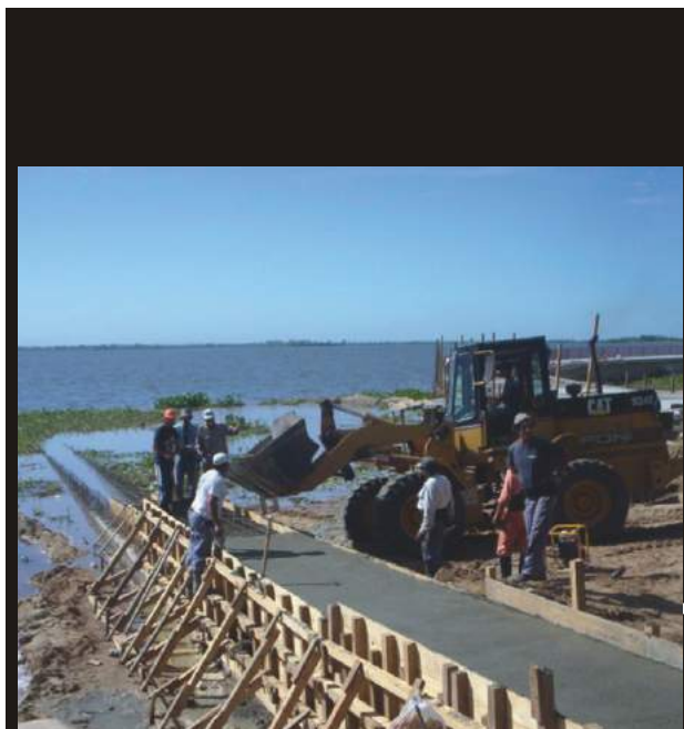
Hormigonado de tapa de conducto de salida sobre Calle Boneo
