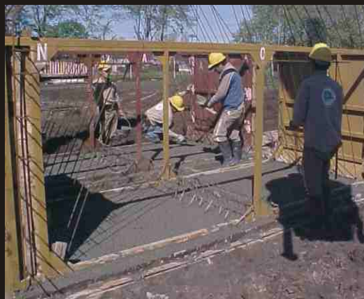
FOTO 022: Hormigonado de tramo de conducto
