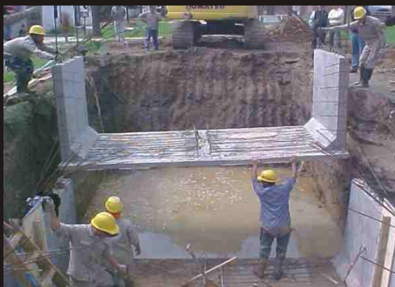
FOTO 016: Montaje de conducto sobre calle Lavaise.
