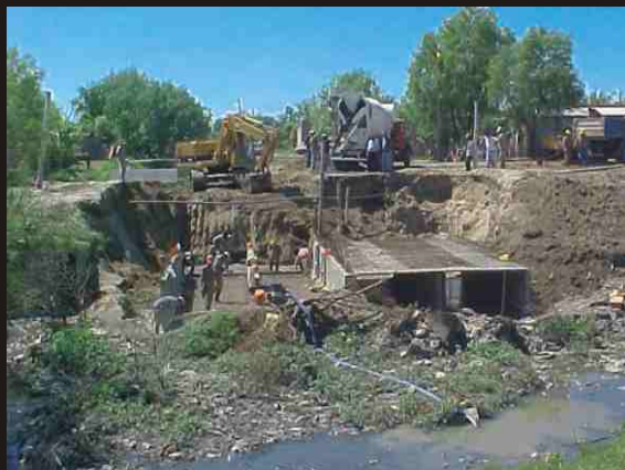
FOTO 008: Salida conducto Entre Ríos sobre reservorio.
