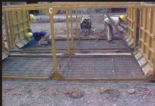
FOTO 002 - Preparación de moldes para confección de tramos de los conductos premoldeados de hormigón a utilizar para la ejecución de los conductos de desagüe.
