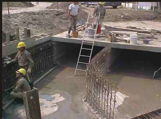
FOTO 007: Preparación de armaduras para la ejecución de los tabiques laterales y divisorios.
