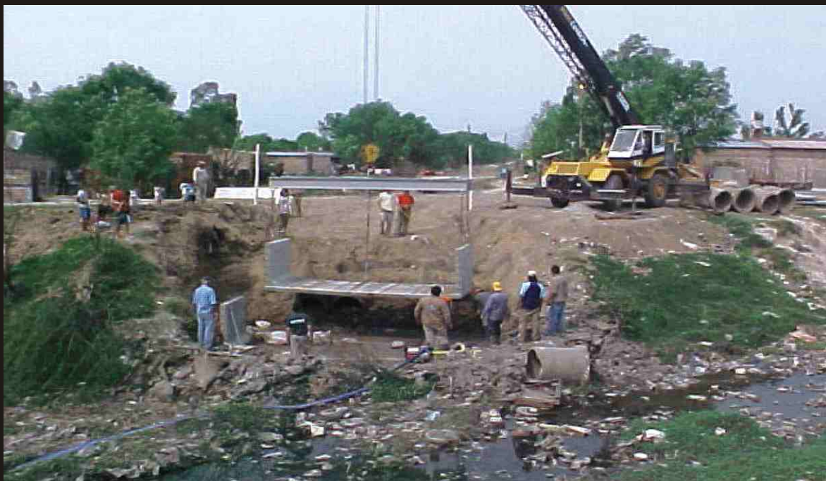
Colocación de tramo de conducto premoldeado en salida del Conducto sobre calle Entre Ríos.
