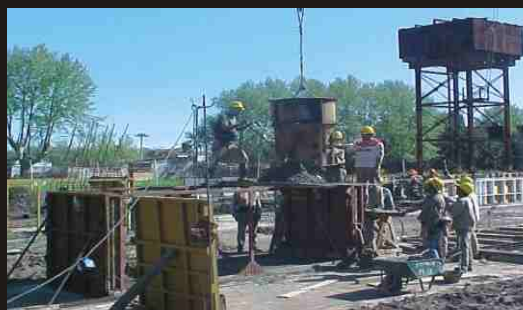
FOTO 012: Hormigonado de muros de conductos.
