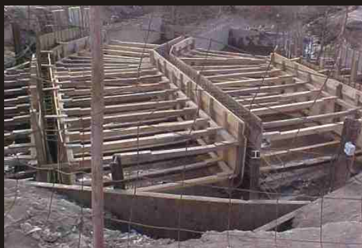
FOTO 035: Preparación de encofrados de tabiques laterales.
