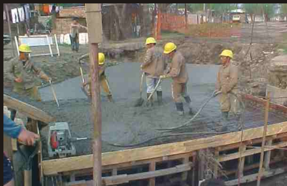
FOTO 034: Hormigonado losa superior conducto doble sobre calle Lavaise próximo al reservorio de Casa Bomba N° 4 en el Oeste de la ciudad.
