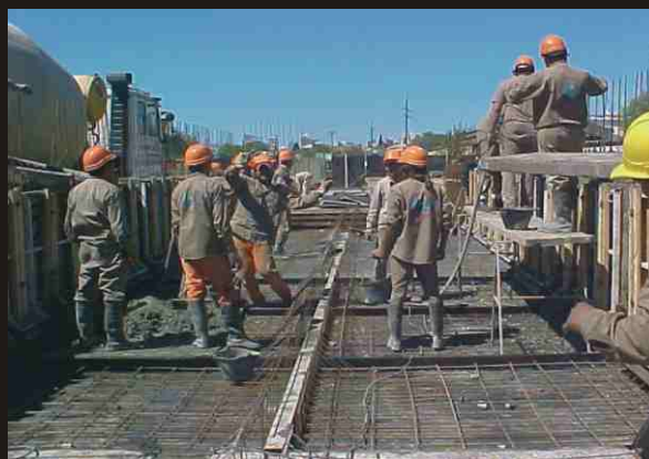
FOTO 117: Hormigonado losa inferior.
