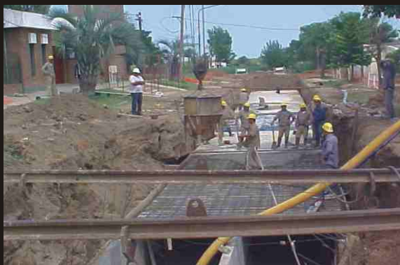
FOTO 001: Hormigonado losa superior conducto doble sobre calle Lavaise próximo al reservorio de Casa Bomba N° 4 en el Oeste de la ciudad.
