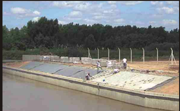
Colocación del revestimiento BETONPLAN®
