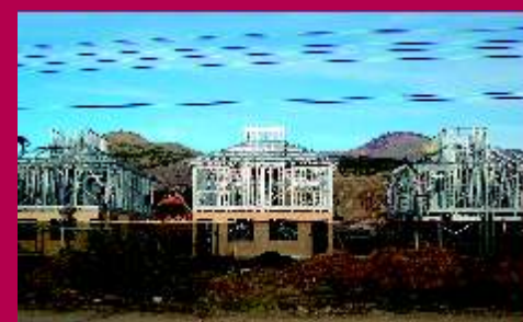
Ensamblado de paneles armados en taller, terminación Siding
