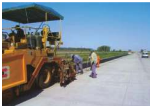
La construcción de banquetas en la Autovía
