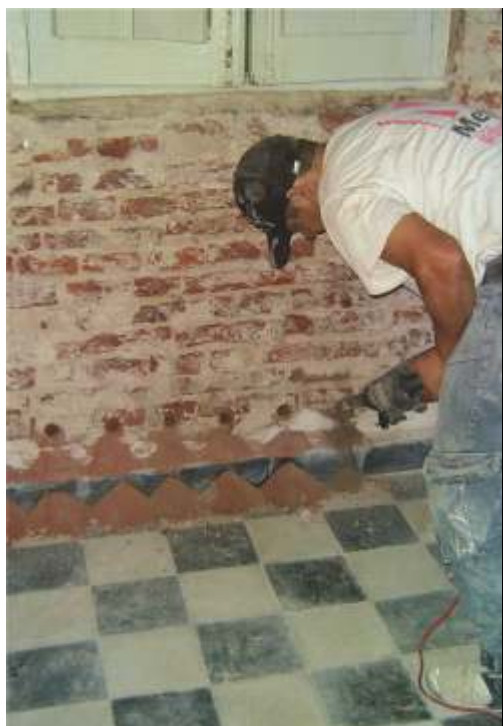
Ejecución de las perforaciones para inyección
