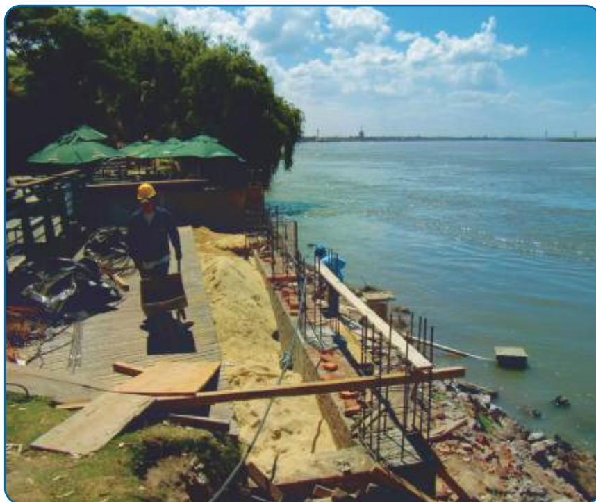
Figura 12. Relleno del trasdós del muro.
