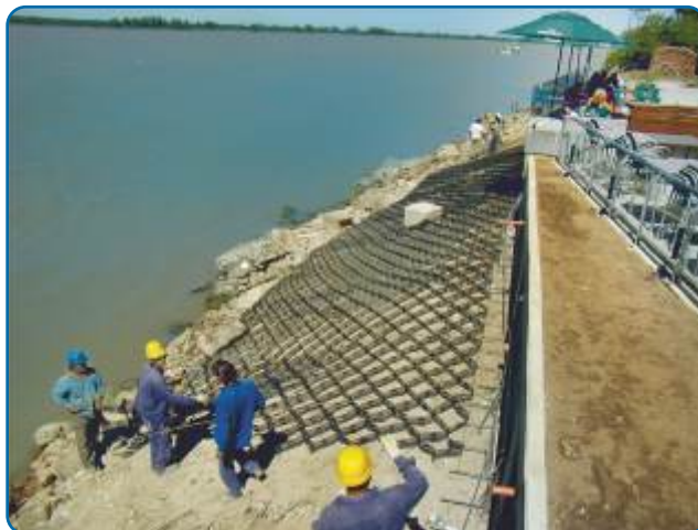
Figura 13. Colocación de las geoceldas
