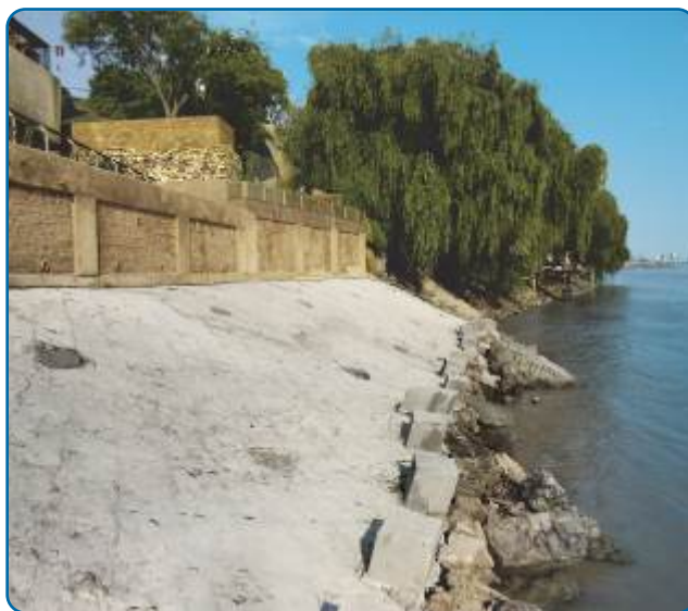
Figura 14. Vista de obra de protección finalizada.
