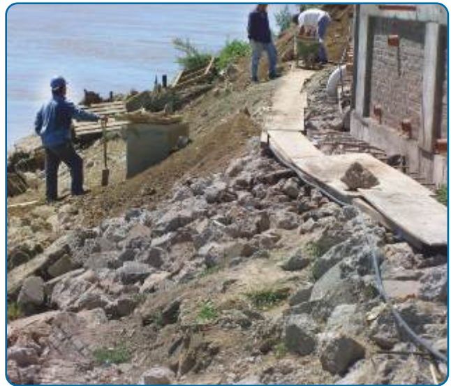
Figura 9. Relleno y compactación del sector de fundación del muro
