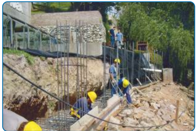
Figura 10. Construcción de las estructuras de fundación y columnas de H°A°.
